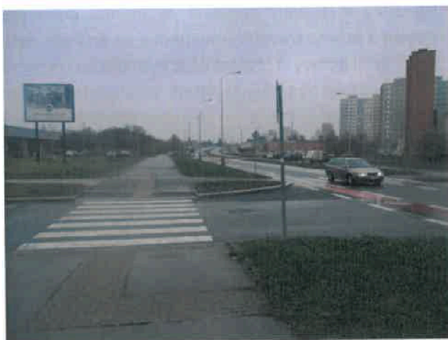
Obrázek 4: Přechod Zbudovská (pohled z druhé strany)
